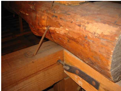
屋根裏点検 金物アリ
