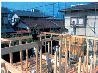
福岡市早良区飯倉 M様邸棟上風景
