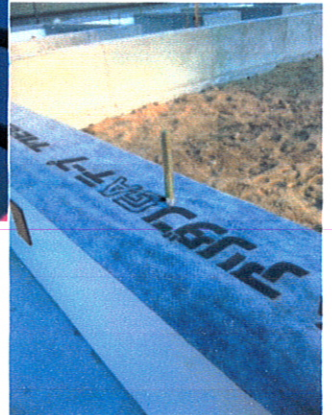
防蟻シート、手間はかかるけど、大切な作業。
