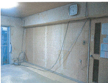
大町団地 S様邸 リノベーション工事
